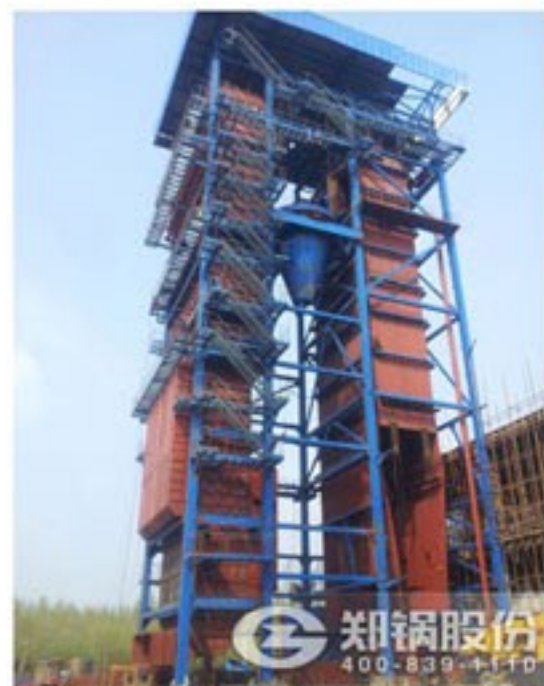
150吨流化床电站锅炉安装现场图片
